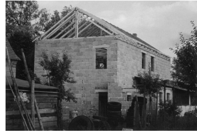
Rohbau von der Rother Straße aus gesehen
