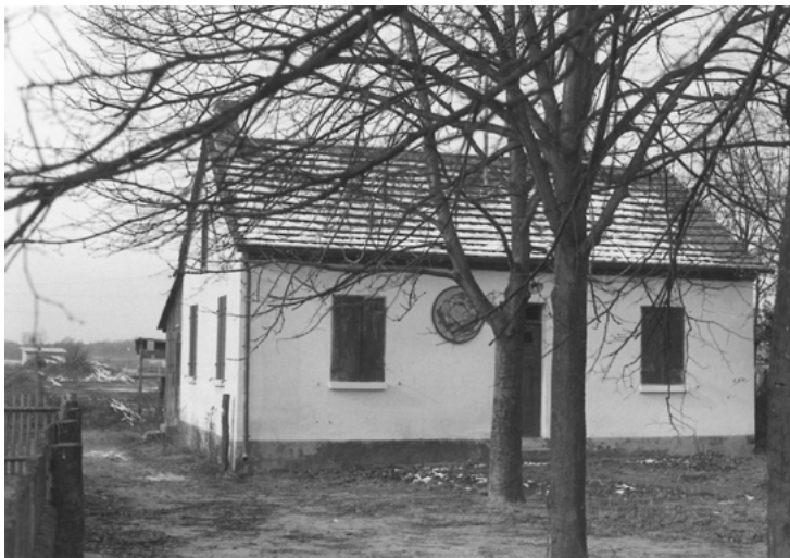
Schützenhaus in der Rother-Straße vor dem Umbau
